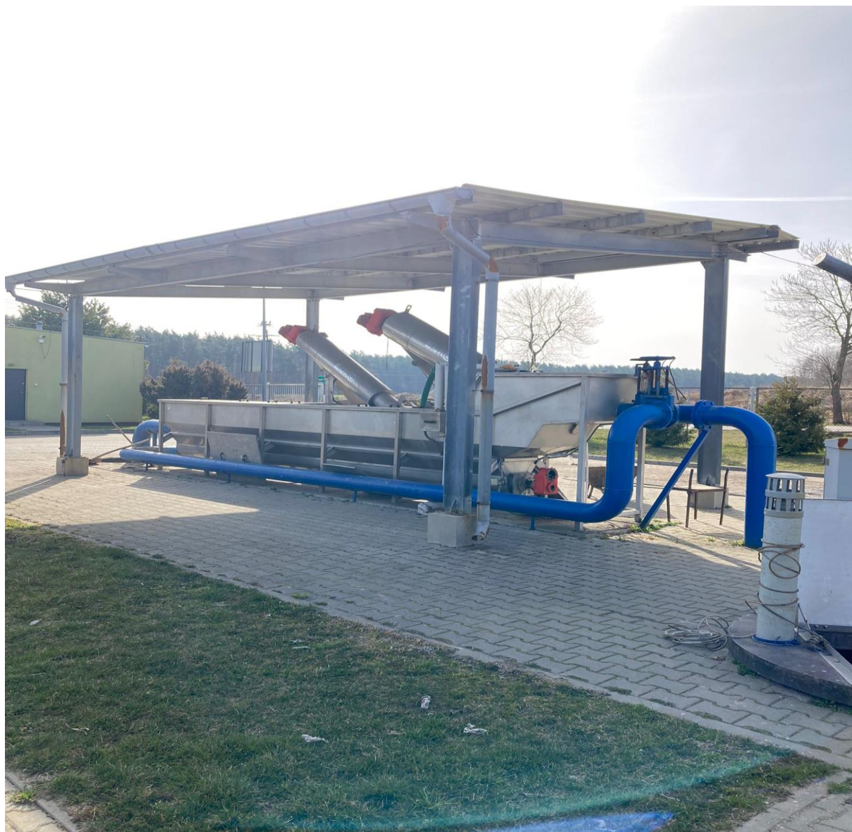
rys. widok na istniejący sitopiaskownik.
