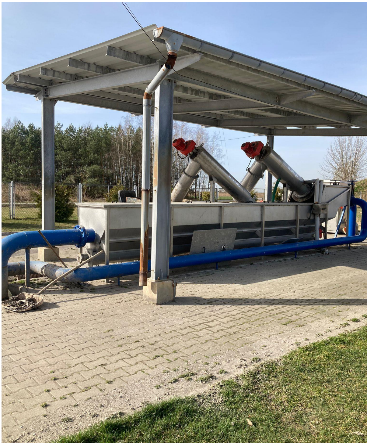
Rys.12 Widok istniejącego sitopiaskownika
