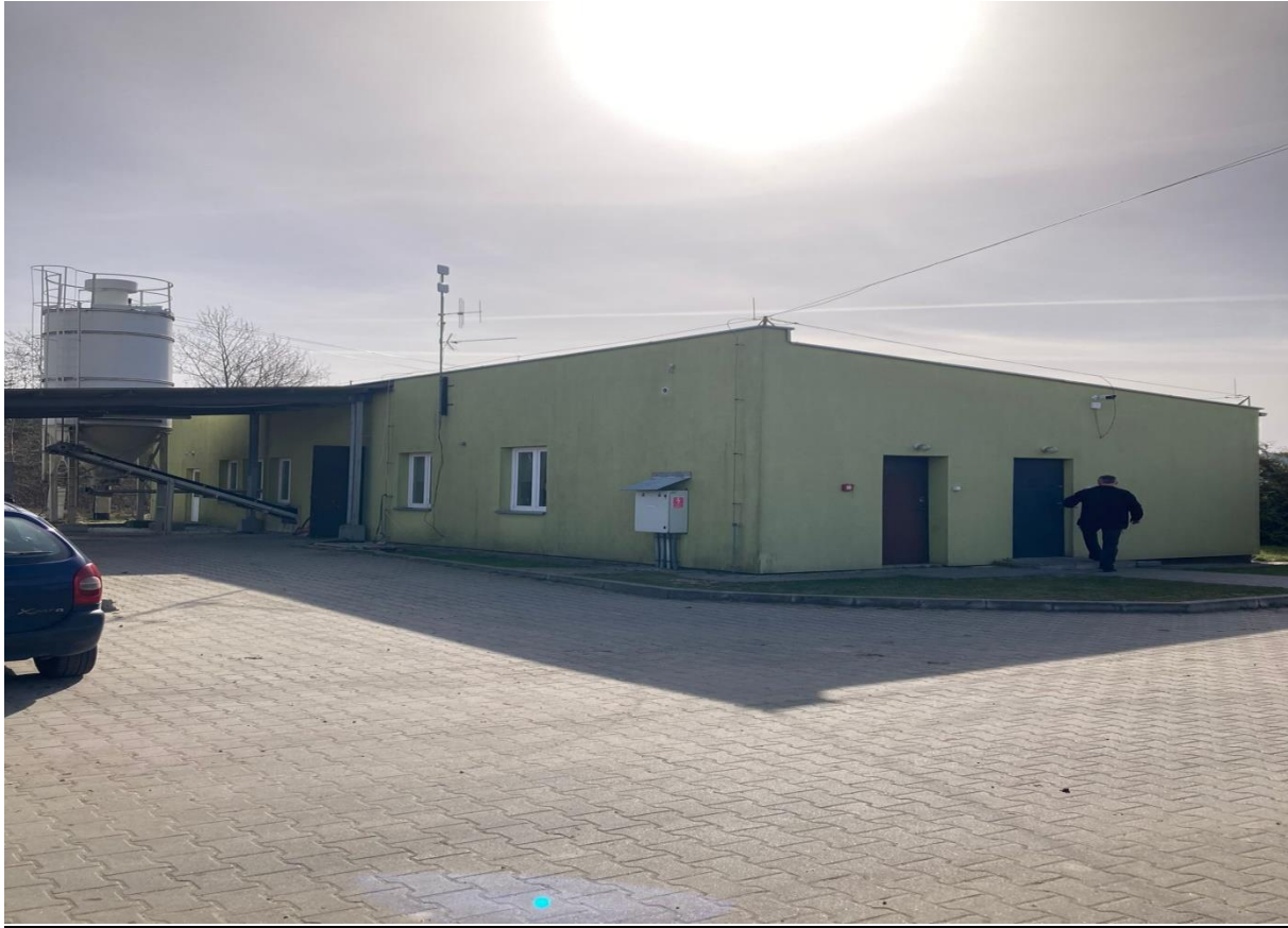
Rys.14 Widok budynku technicznego – dach do montażu paneli fotowoltaicznych
