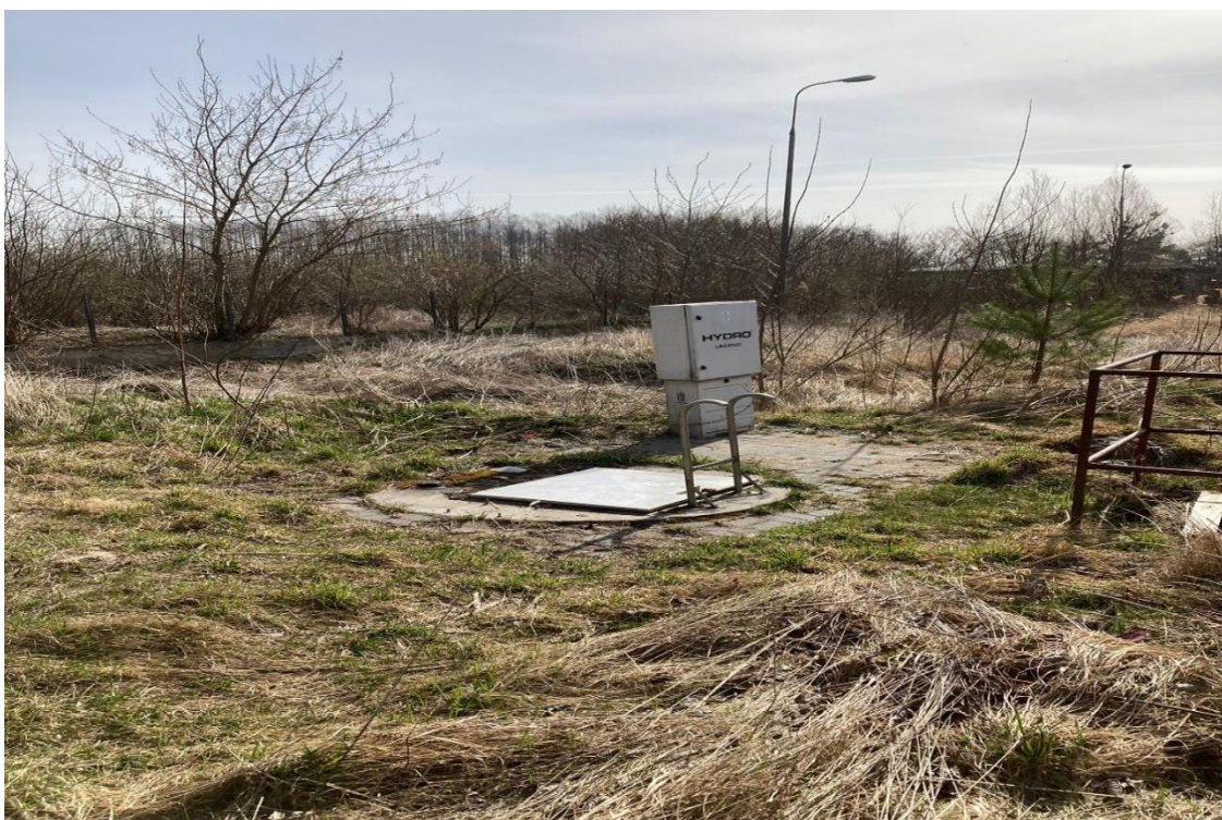
Rys.19 Widok przepompowni ścieków
