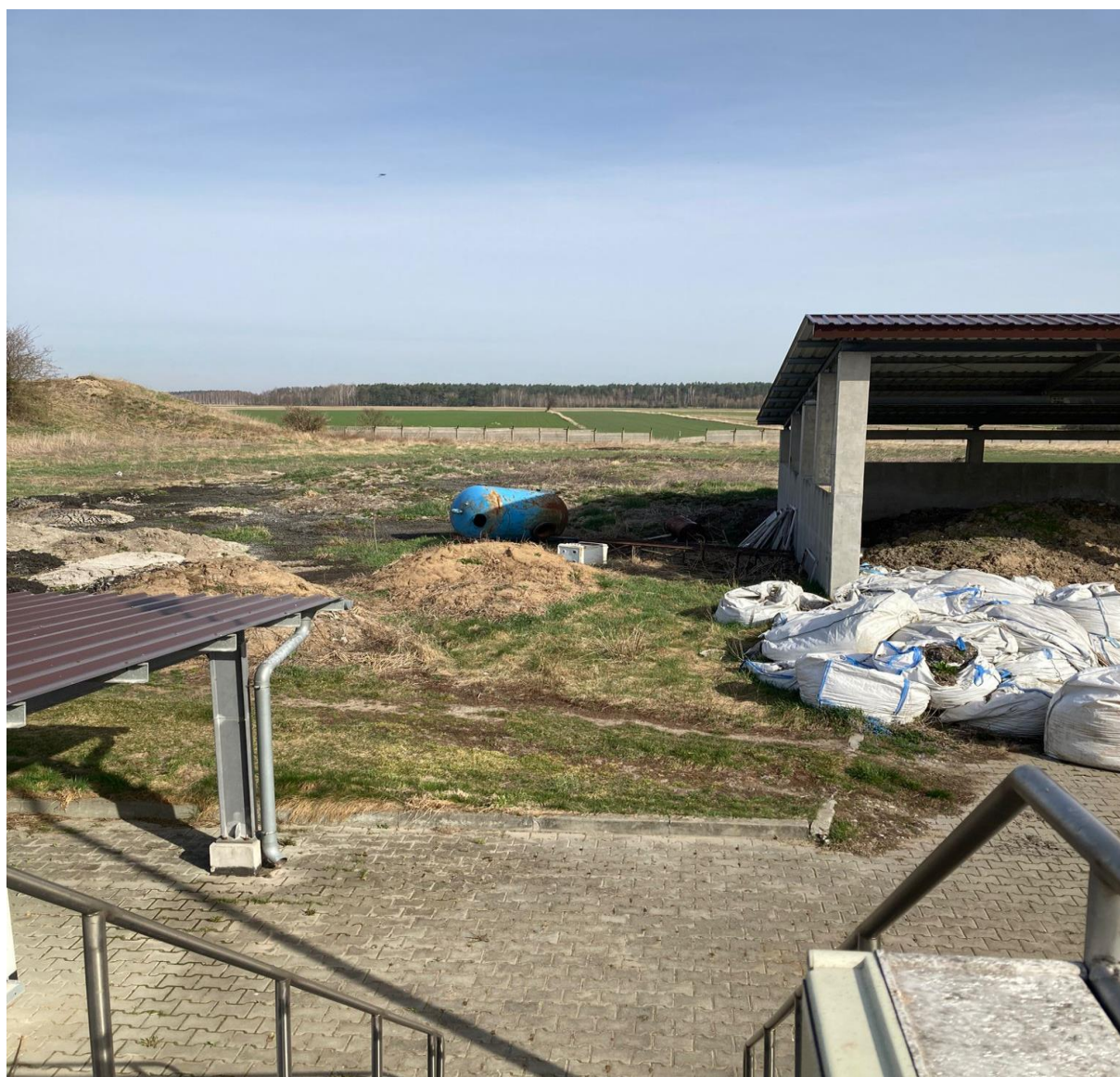
Rys.13 Widok terenu pod budowę suszarni osadów
