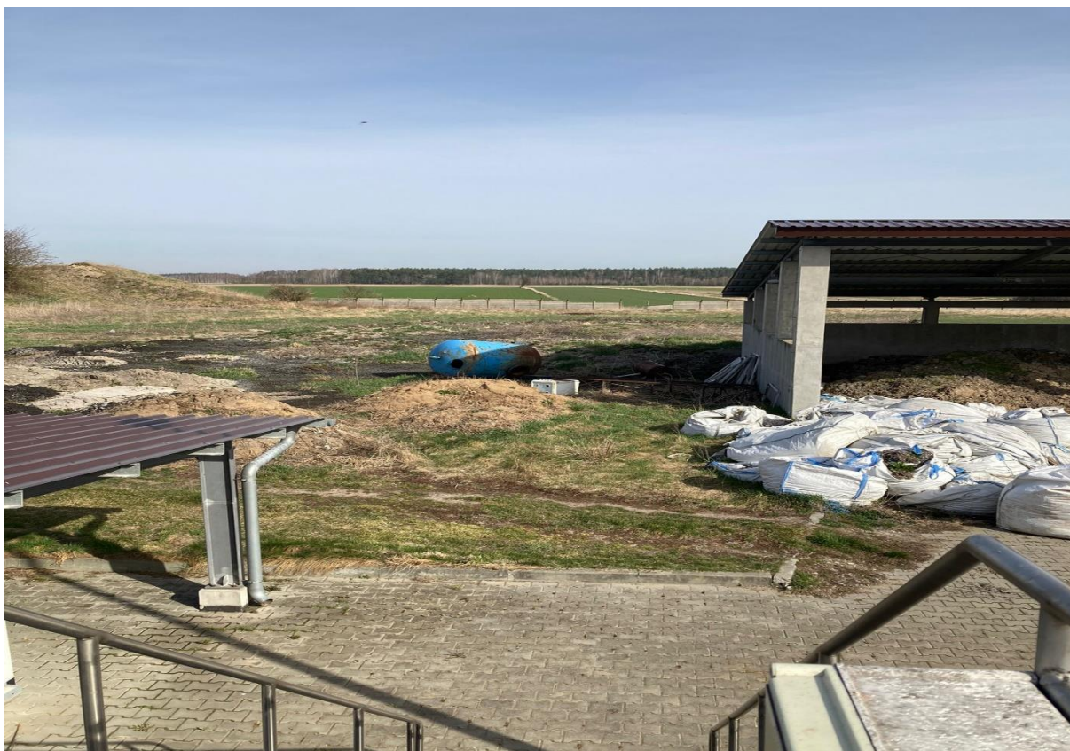
Rys. 25 lokalizacja suszami osadów (obok istniejącej wiaty)
