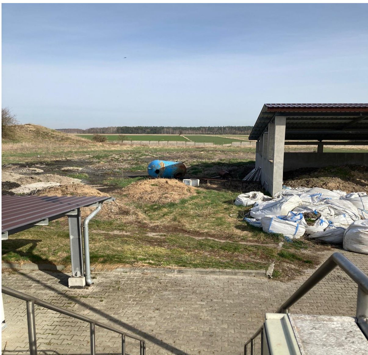
Rys.13 Widok terenu pod budowę suszarni osadów
