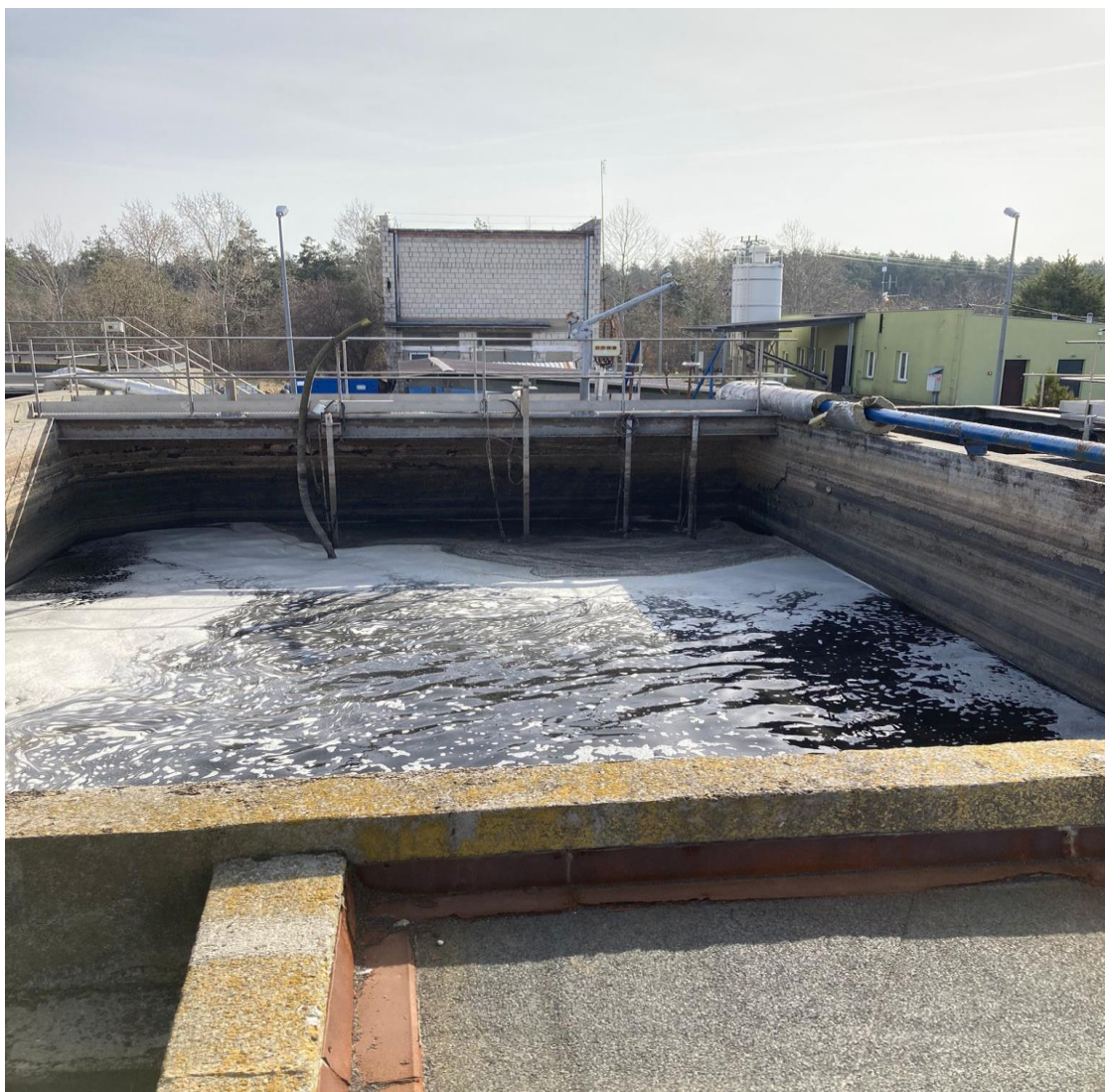
rys.21 widok na istniejący zbiornik ścieków surowych (w głębi podest obsługowy, po prawej rurociąg doprowadzający ścieki)
