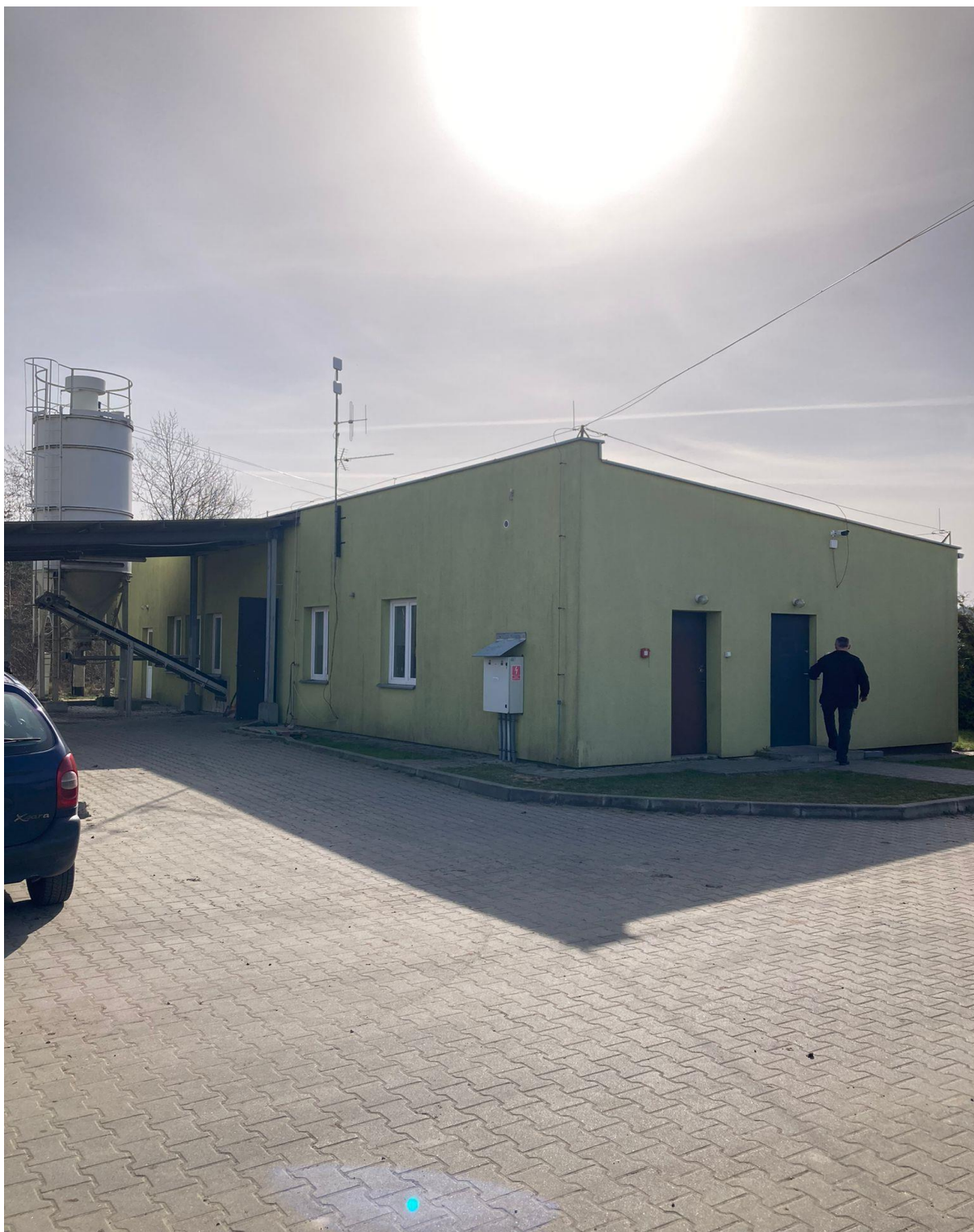
Rys.14 Widok budynku technicznego – dach do montażu paneli fotowoltaicznych
