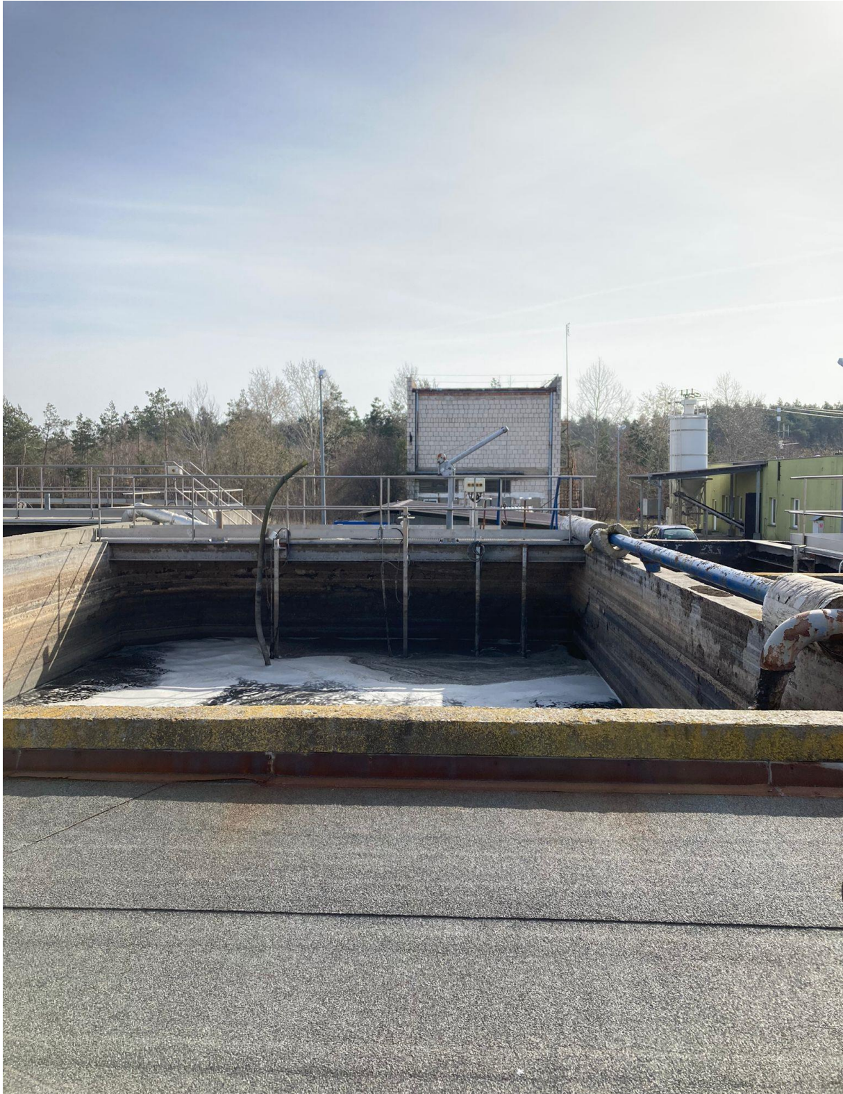
Rys.9 Widok zbiornika retencyjnego ścieków surowych
