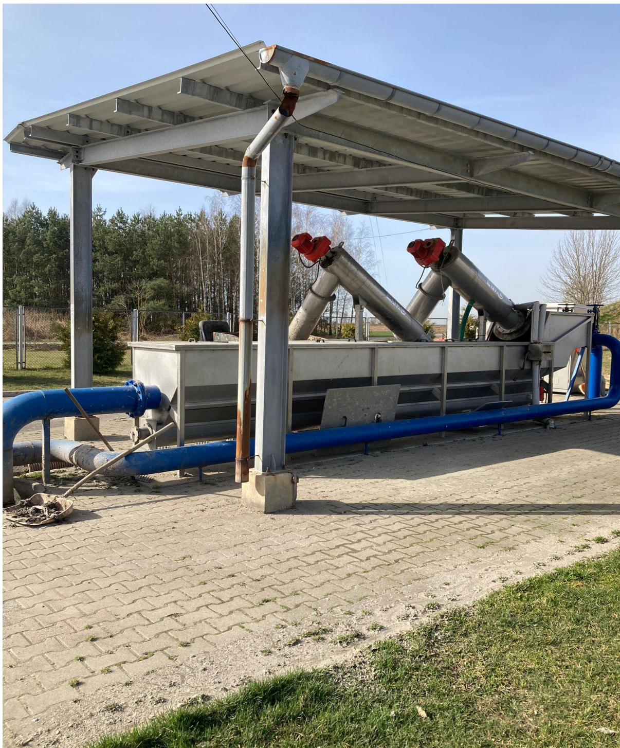
Rys.12 Widok istniejącego sitopiaskownika
