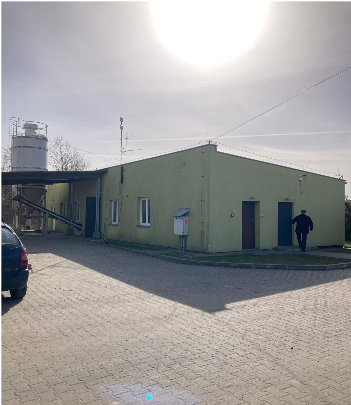
Rys.27 widok budynku technicznego oczyszczalni ścieków
