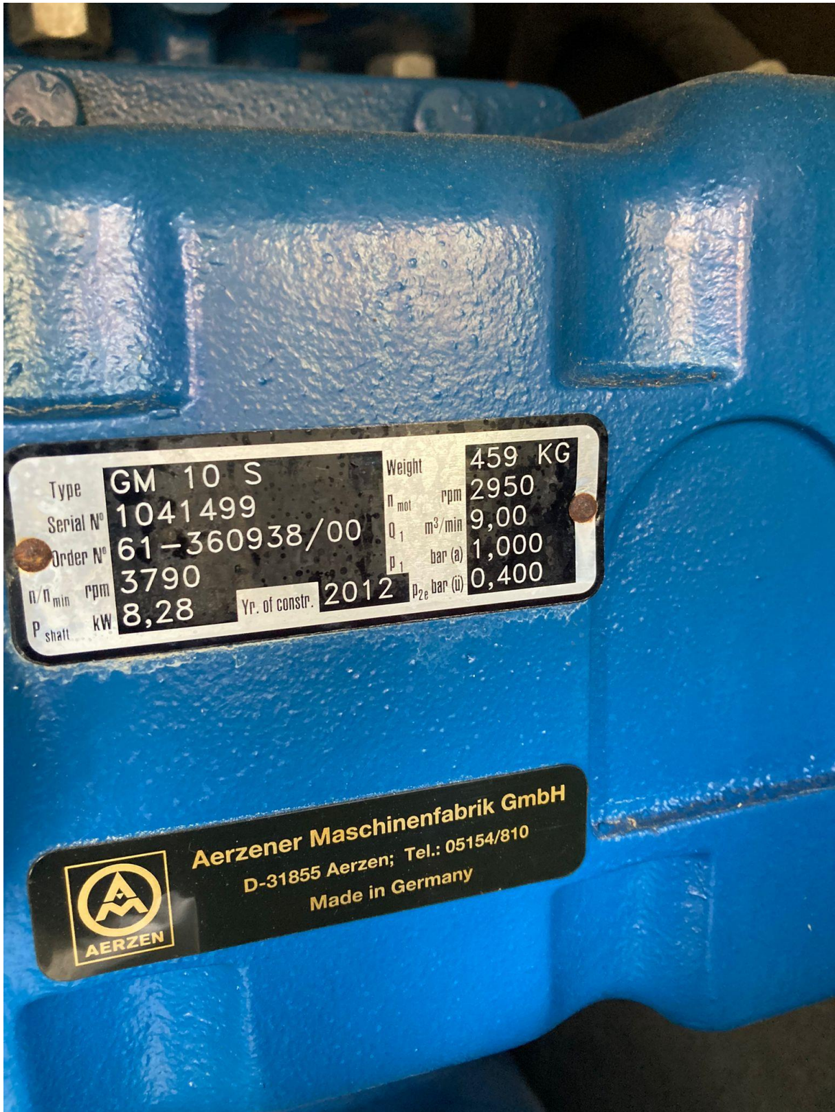
Rys.12 tabliczka znamionowa istniejących dmuchaw
