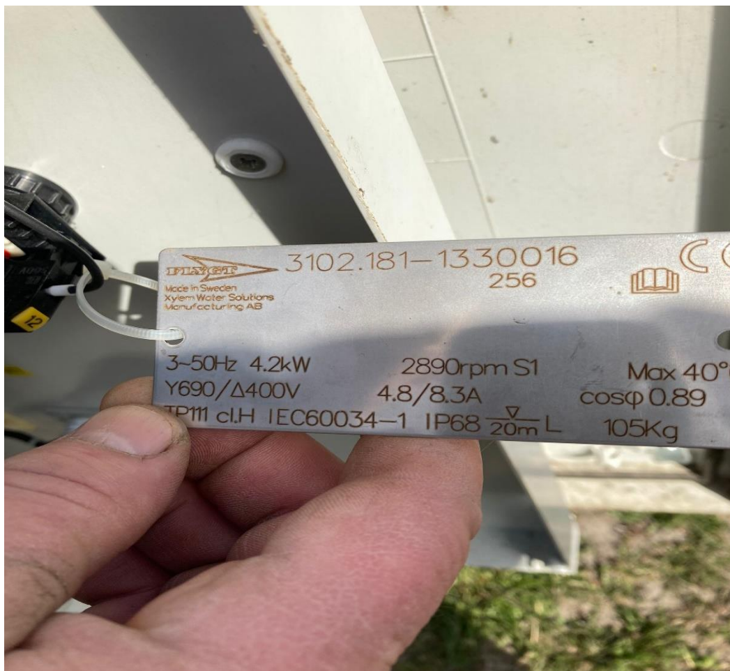
Rys.17 Tabliczka znamionowa pomp w przepompowniach – do wymiany 4 szt po 2 szt. w każdej przepompowni
