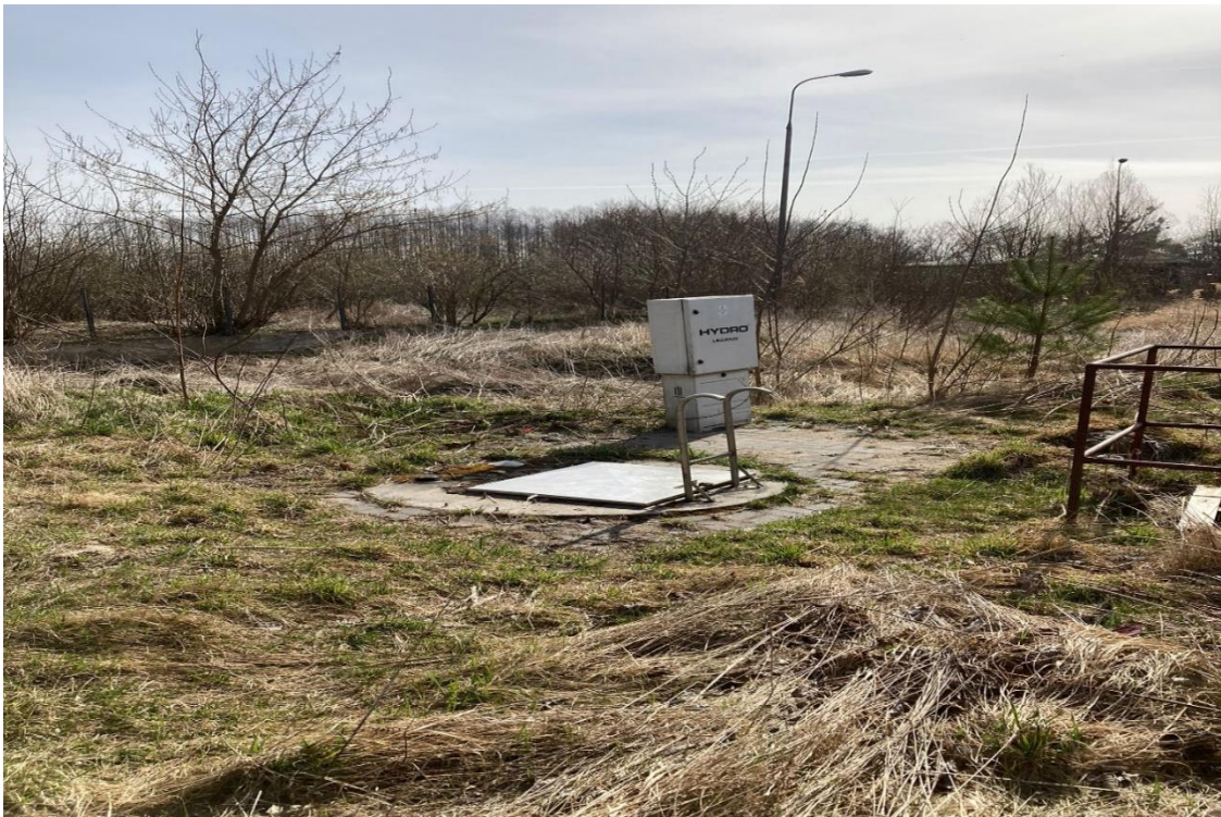
Rys.19 Widok przepompowni ścieków
